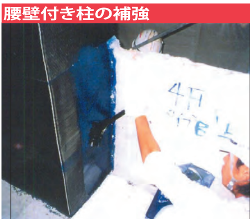
サッシを付けたままの補強
