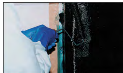
CFアンカーの貼付け
