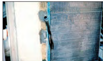
CFアンカーの挿入
