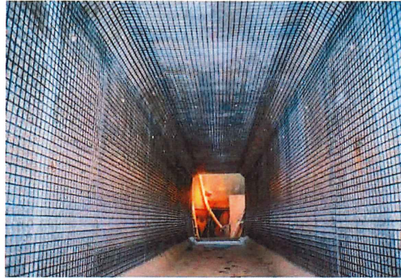
ボックスカルバートの補強
