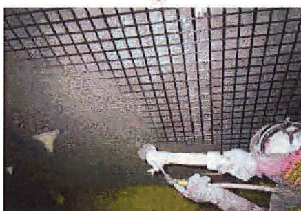
モルタル吹付状況
