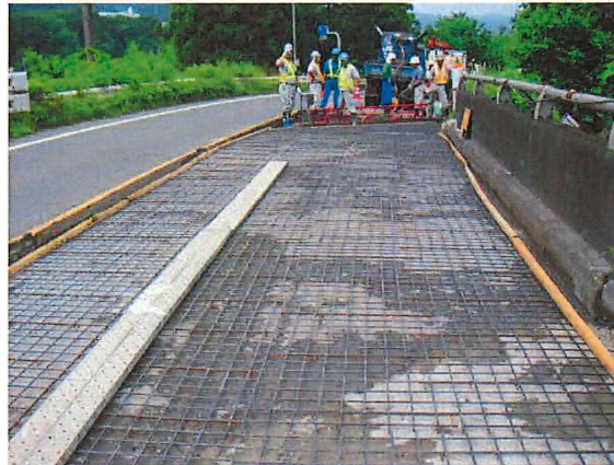
床版上面の補強
