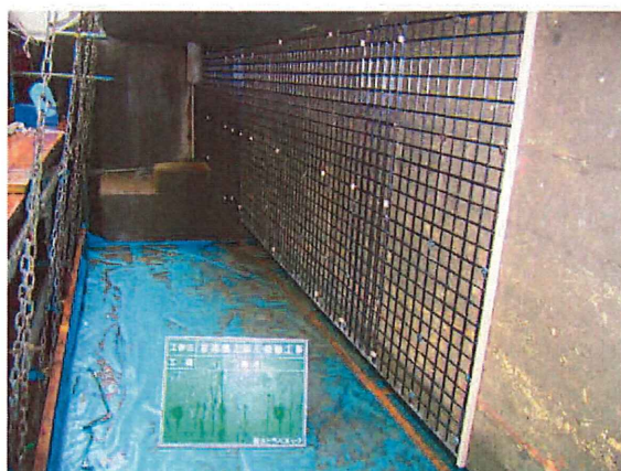
FRPグリッド取付完了
