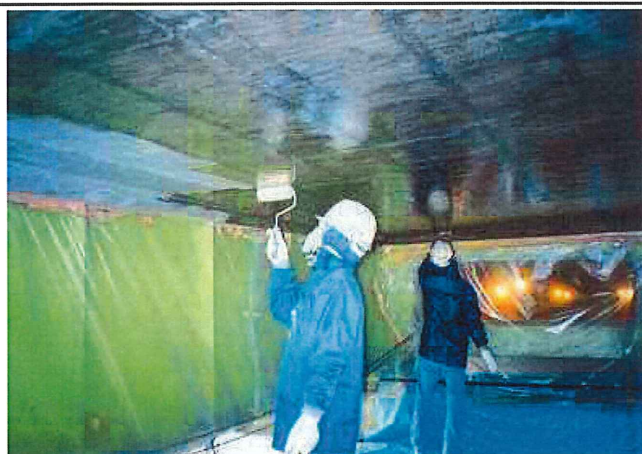
施工写真①プライマー塗布
