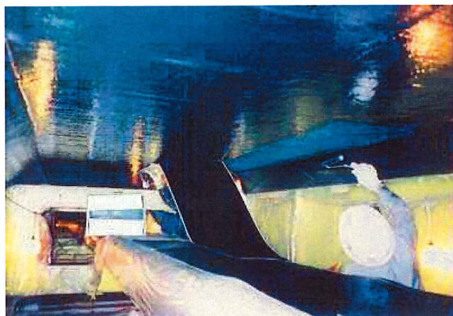
トウシート施工状況
