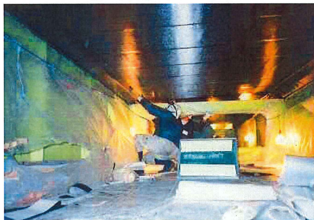
施工写真②トウシート接着
