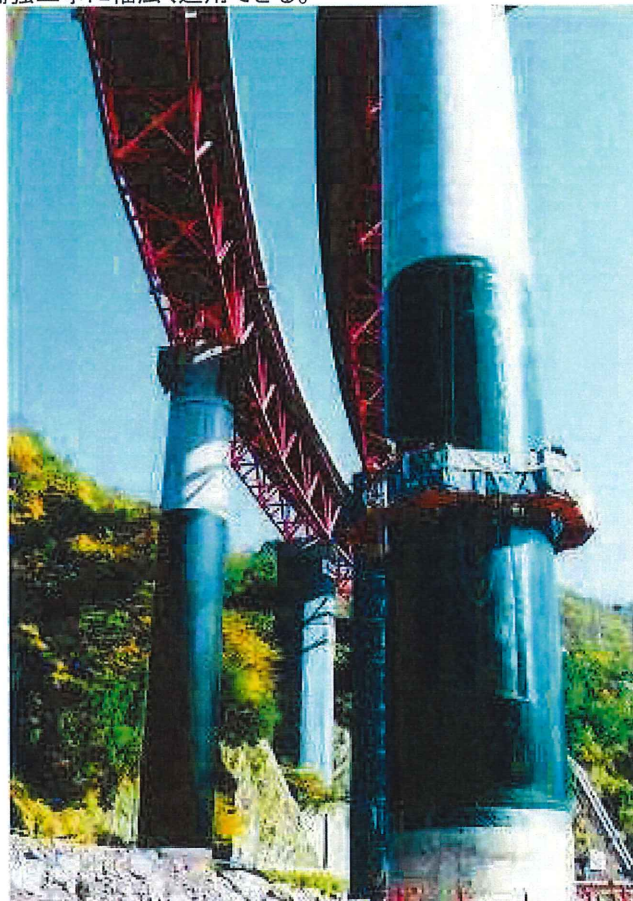
トウシート施工例(橋脚)
