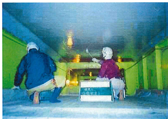
施工写真③仕上げ塗装
