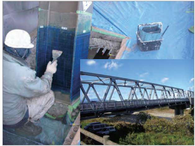
■鋼トラス橋／斜材
