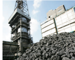
ニードルコークス製造設備
