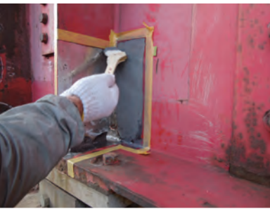
■プライマー塗布
