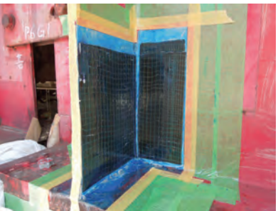
■炭素繊維シート貼付け
