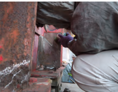
■錆び、旧塗膜の除去
