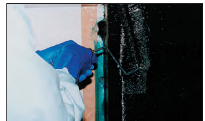
CFアンカーの貼付け
