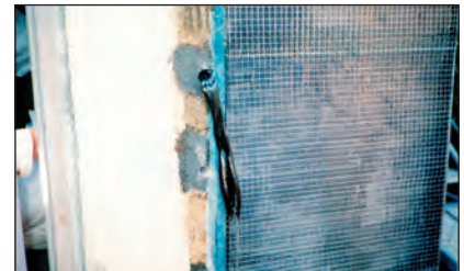
CFアンカーの挿入
