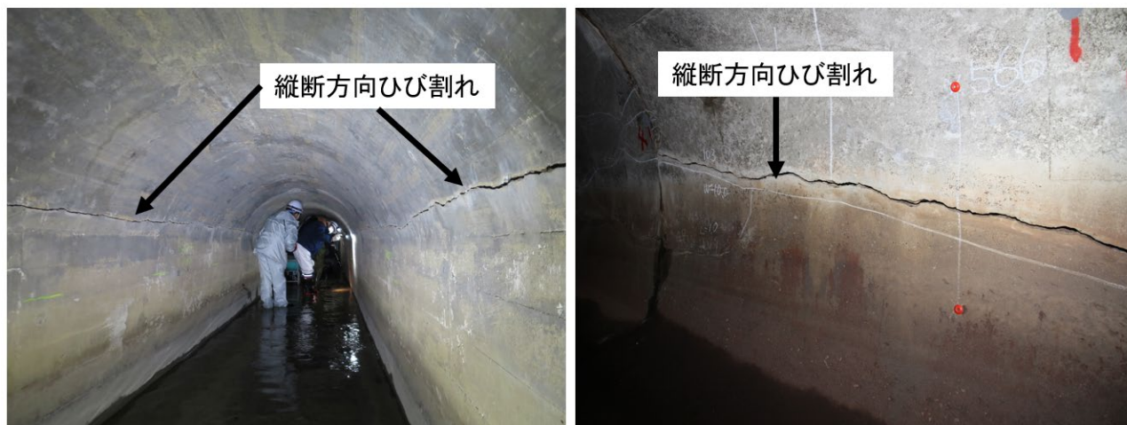
図 1 水路トンネルに見られる典型的なひび割れの事例。場所は水路トンネルの左右側壁の肩部に見られ、縦断方向に連続していることもある。
