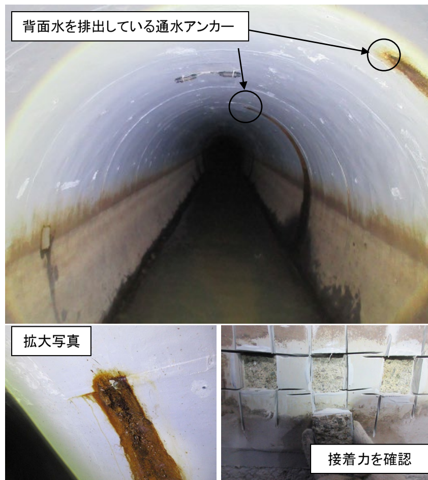
図5 試験施工を行った水路トンネル（東北地方）におけるモニタリング
