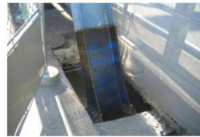
【ストランドシート®黒：炭素繊維、黄：アラミド】 【ストランドシート®を利用した鋼斜材施工例】
