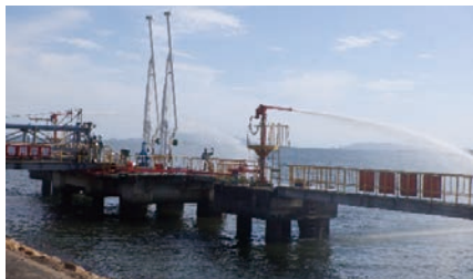
放水銃放水訓練
