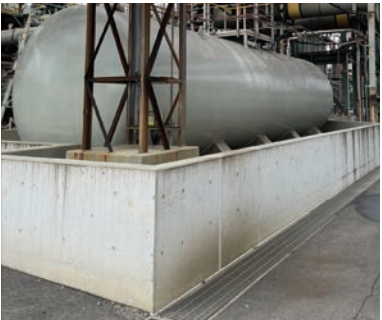
タンク防液堤(九州製造所)
