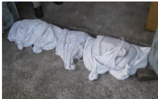
土のうの積み上げ状況
