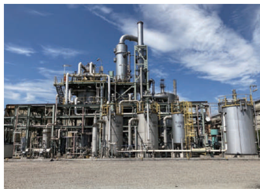
対策例: オフガス処理設備 (姫路製造所)
