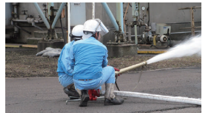
消火栓による初期消火
