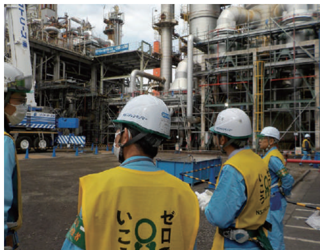
定期検査工事期間中パトロール
